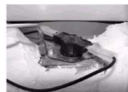
Rys. 22. Przycisk na ograniczniku temperatury
